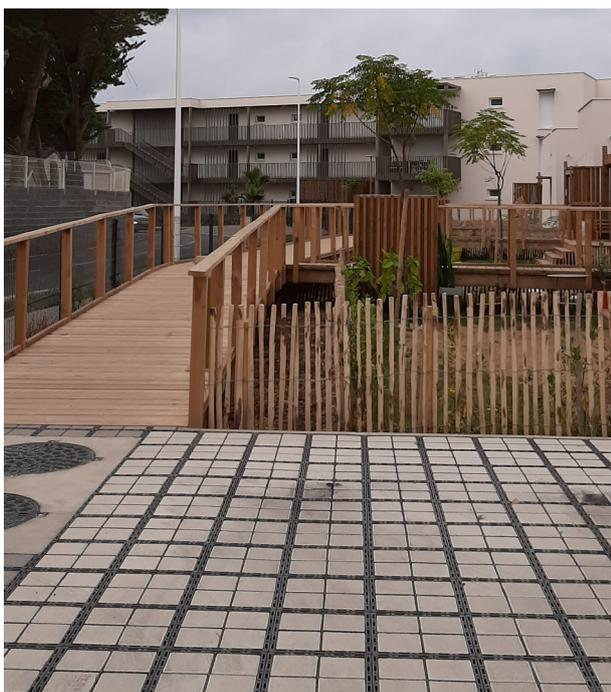
Un parking aérien situé en zone rouge, perméable grâce à des dalles alvéolées et des gravillons qui recouvre un bassin de rétention de 320 m<sup>3</sup>.
